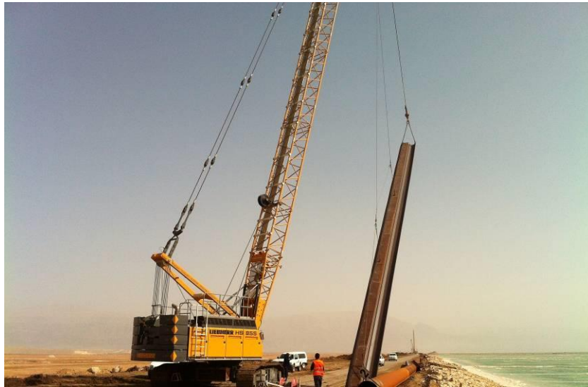
Abbildung 10: Aufrichten eines Spundwandelementes
