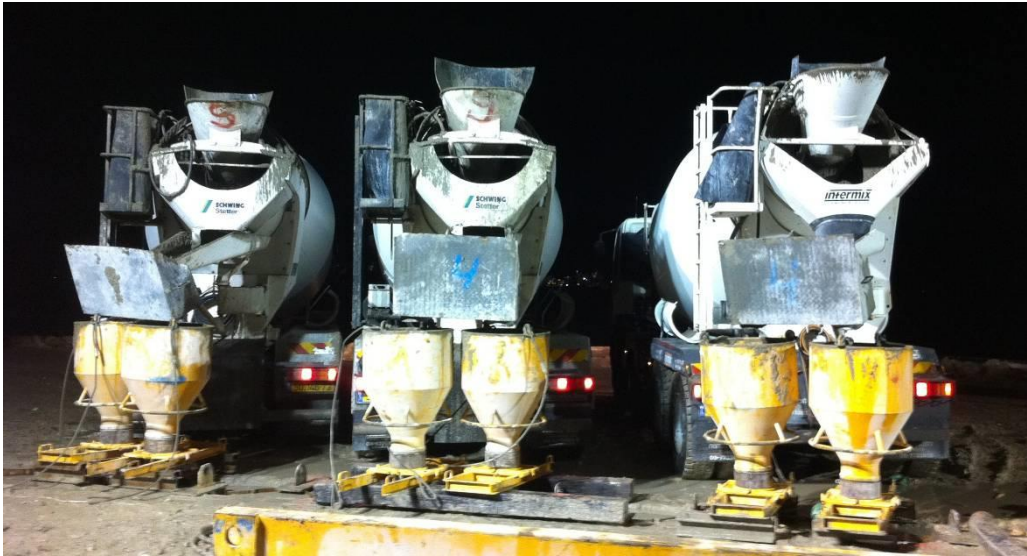
Abbildung 11: Betonage beidseitig der Spundwände
