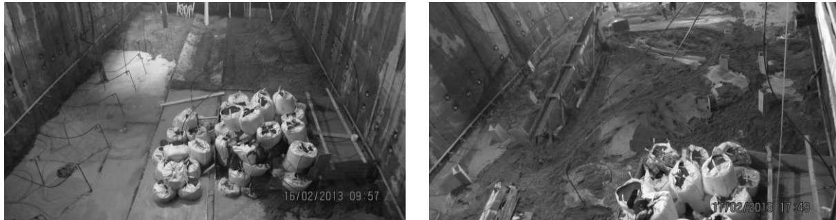
Abbildung 6: Versiegelung und Ballastierung der Baugrubensohle
