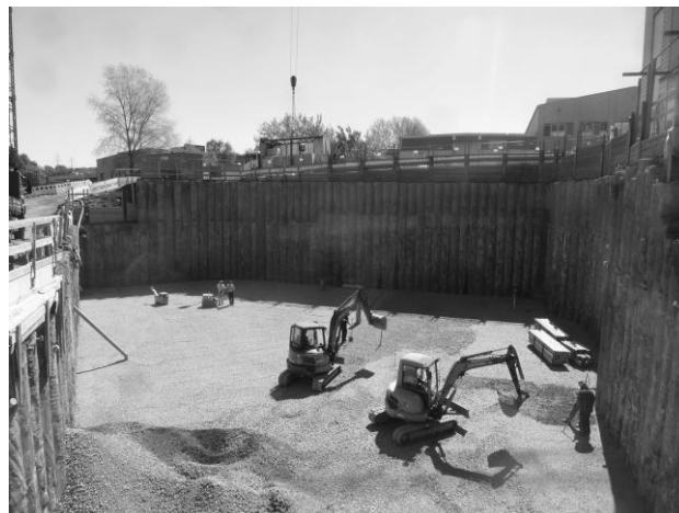
Abbildung 11: Endaushubniveau mit Einbau des Flächenfilters
