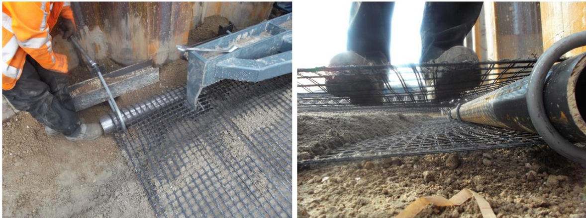
(a) Befestigung des Geogitters
