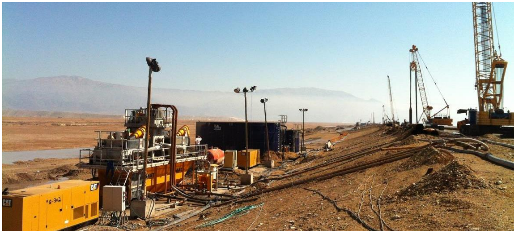
Abbildung 7: Schlitzwandfräseinheit inkl. Entsandungsanlage und Vorratsbehältern
